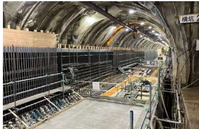
低土被り区間 下り線底部 構築状況
