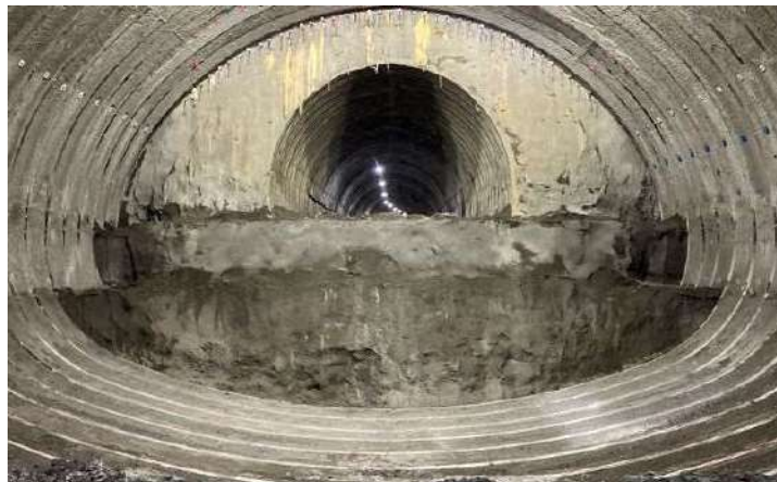
分合流区間（下り線） 掘削状況
