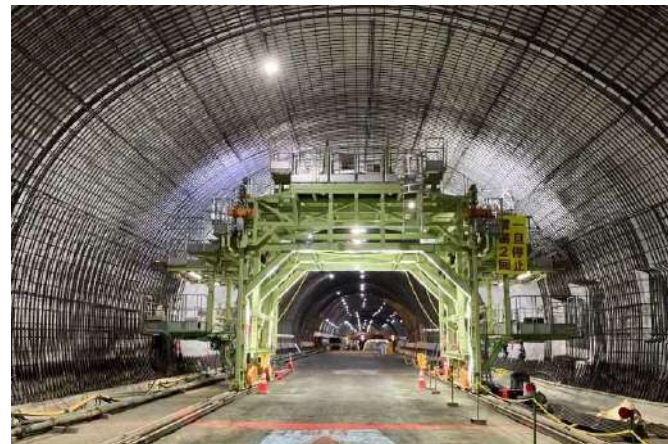
釜利谷西トンネル（上り線）（仮称） 覆工コンクリート施工状況
