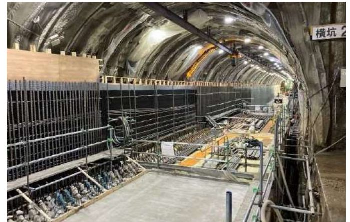
低土被り区間 下り線底部 構築状況
