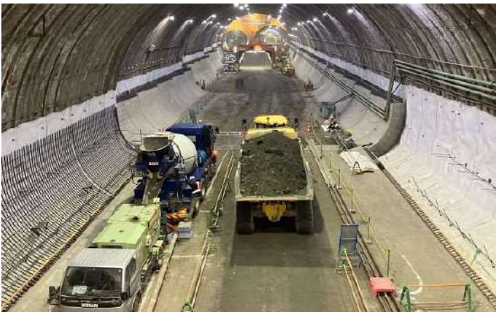
分合流区間（上り線） 側壁コンクリート施工状況
