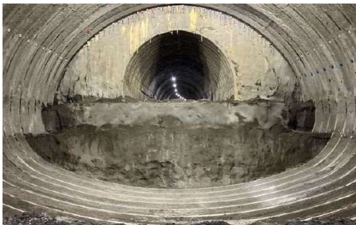
分合流区間（下り線） 掘削状況
