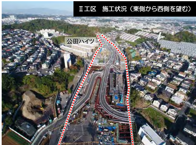
III 工区 施工状況（東側から西側を望む）
