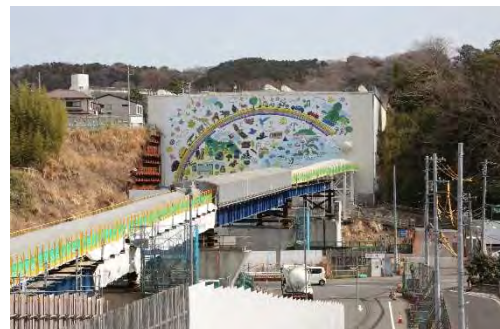
ベルトコンベア設置状況
