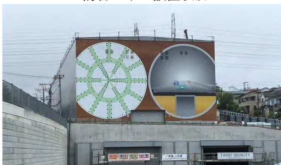
防音ハウス設置状況
