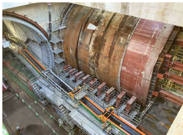
立坑内写真(R5.12.13撮影)
