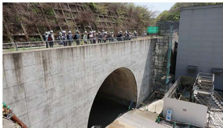
○釜利谷開口部 釜利谷JCTの改変面積の縮小 従来の自然環境を極力残すために切土構造からトンネル構造へ変更した場所を見学します
