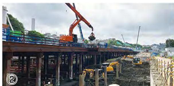
掘削した土砂を工事用仮橋から搬出します
