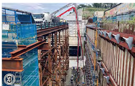
工事用仮橋からコンクリートを打設し、トンネルの本体をつくっています
