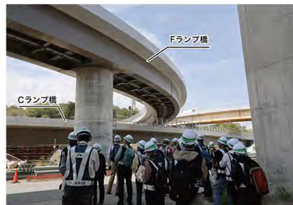
○Fランプ橋、Cランプ橋 よこかんみなみ の工事現場では釜利谷ジャンクションに増設されるランプの橋梁について、架設方法や周囲の景観に配慮した桁色(茶毛ねずみ色)を紹介しました
