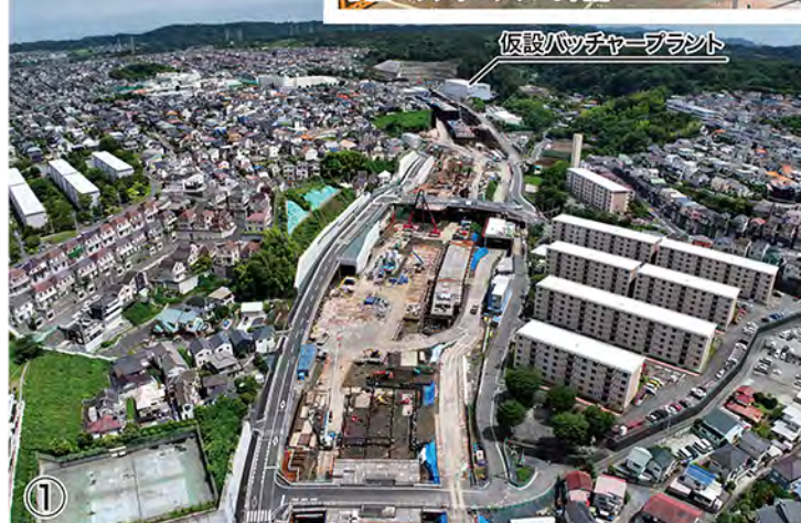
公田インターチェンジ(仮称)付近の状況
