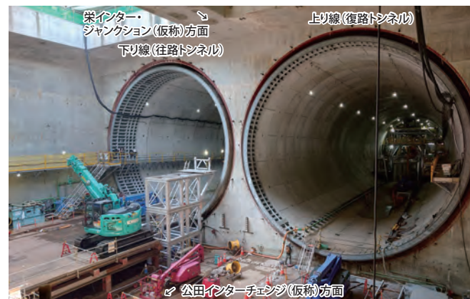
公田笠間トンネル回転立坑内部
