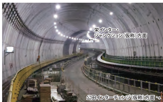
下り線(往路トンネル)内部
