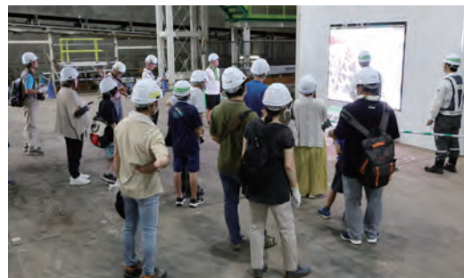
回転立坑内部を見学。シールドマシン回転のようすをビデオで説明
