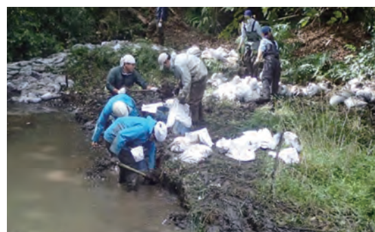
人の手で土砂の除去作業を行っています
