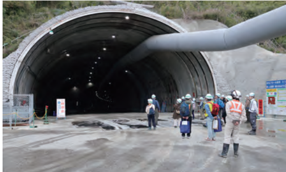
○釜利谷ジャンクションランプ第一トンネル 環境保全に取り組んだ事例をご説明しました(切土区間の一部をトンネル構造に変更)
