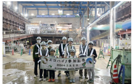
○防音ハウス内 トンネル掘削に伴う騒音等を低減させるために設置した防音ハウス内で参加者の皆さまと集合写真を撮りました
