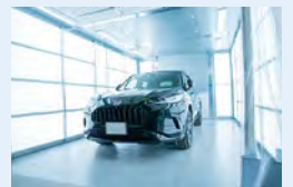
▲オートテックベース湘南の塗装・乾燥ブース
