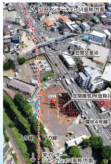
笠間換気所(仮称)付近
