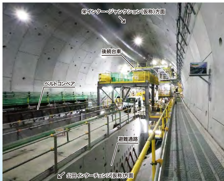
復路トンネル(上り線)坑内
