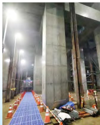
笠間換気所(仮称)地下5階内部
